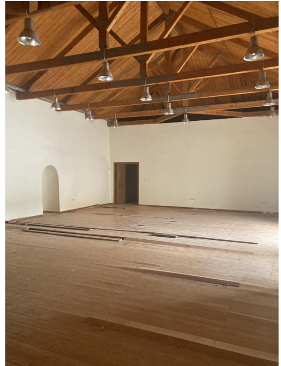
Εικόνα 3: Μεγάλη Αίθουσα κτιρίου
