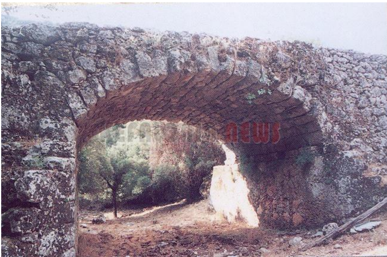
Το γεφύρι του Λάλα στο δρόμο Δρακάτα-Φάλαρη
