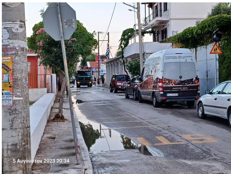
Φωτ. 5 Καθαρισμός φρεατίων μπροστά από το Α.Τ. Ληξουρίου
