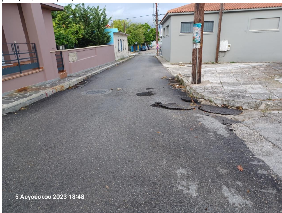
Φωτ. 2 Αποξήλωση οδοστρώματος στην οδό Ελ. Βενιζέλου όπου πολύ πρόσφατα είχε γίνει η ασφαλτόστρωση
