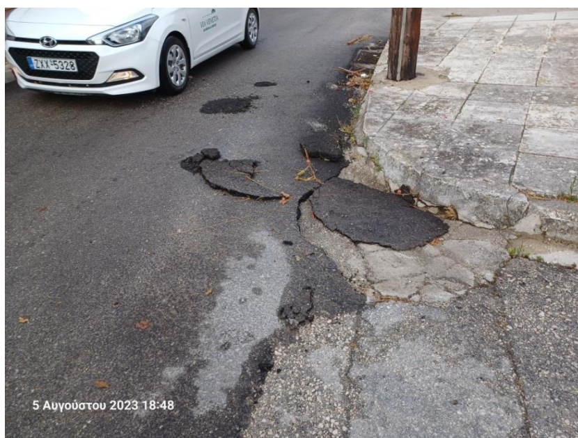
Φωτ. 1 Αποξήλωση οδοστρώματος στην οδό Ελ. Βενιζέλου όπου πολύ πρόσφατα είχε γίνει η ασφαλτόστρωση
