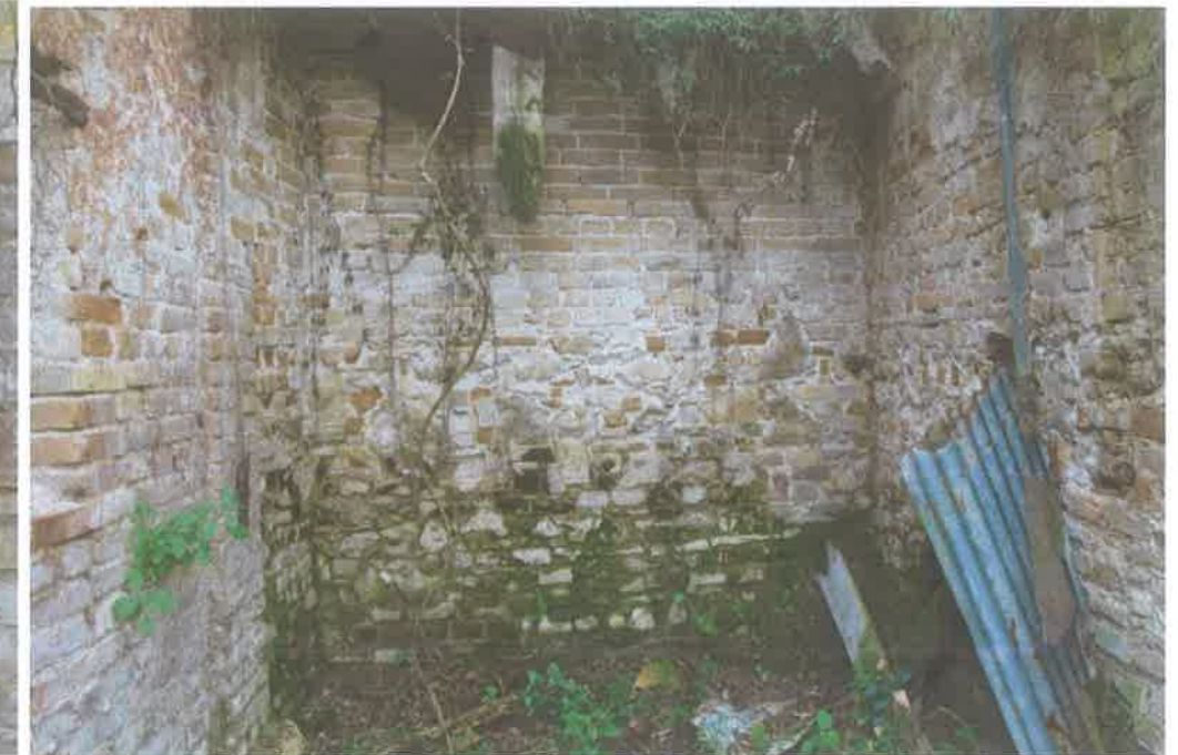
Φωτ. 56. χ.ΙΣ.06 κατασκευαστικά ανομοιογενές αποτέλεσμα στην τοιχοποιία
