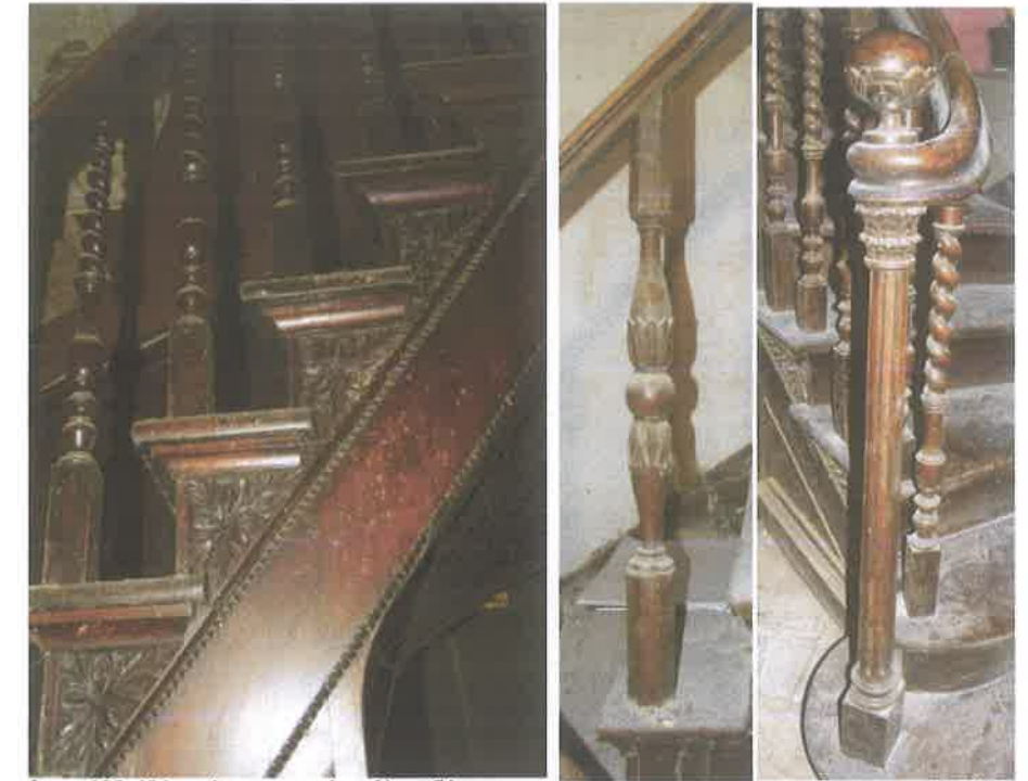
Φωτ. 126. I01 από ερευνητικό σκάλες τζάκια Ξύλινος διάκοσμος στο κεντρικό κλιμακοστάσιο της οικίας Πηγή: Ερευνητικό Ε.Μ.Π.
