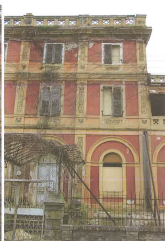
Φωτ. 175. φθορές στα κουφώματα/ρωγμές στο επίπεδο έδρασης των μεταλλικών δοκών οροφής β ορόφου/έντονη υγρασία στο επίπεδο του δώματος που ευνοεί την ανάπτυξη φυτικών οργανισμών
