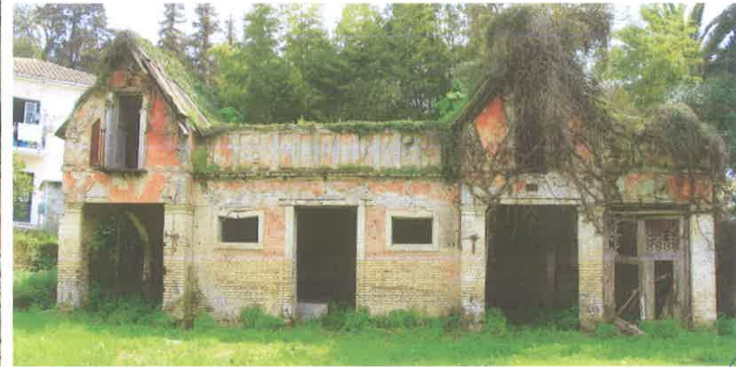
Φωτ. 133. Η υφιστάμενη κατάσταση της κύριας όψης του κτίσματος.
