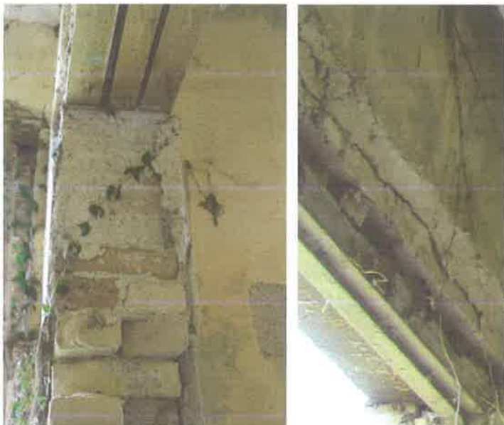
Φωτ. 74. χ.ΙΣ.02 διαμόρφωση εσωτερικού πρεκιού
