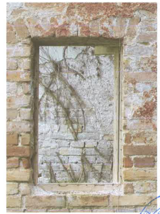
Φωτ. 70. κορνίζα οπτόπλινθων σε συνδυασμό με ανακουφιστικό τόξο
