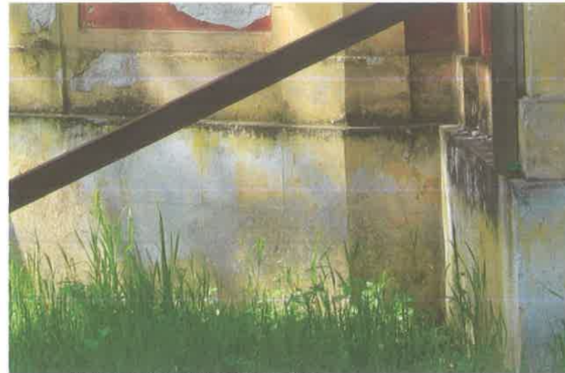
Φωτ. 97. Μίμηση ισόδομης λιθοδομής στη βάση του κτίσματος.
