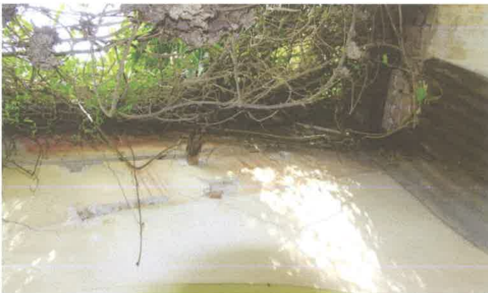
Φωτ. 62. χ.ΙΣ.04 ίχνη από δοκούς στήριξης οριζόντιας οροφής και κεκλιμένης στέγας
