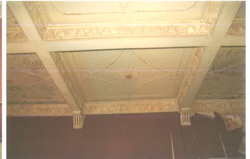
Φωτ. 119. Η χρήση του ξύλου ως υλικού επένδυσης σε τμήμα της τοιχοποιίας του χώρου εισόδου Ι.01 Φωτ. 120. "Φατνωματική" οροφή στο χώρο Ι.01 _ Πηγή: Ερευνητικό Ε.Μ.Π.
