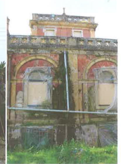
Φωτ. 236. βορειοανατολική όψη
