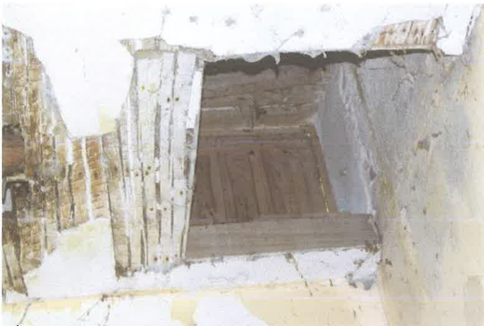
Φωτ. 61. χ.ΙΣ.02 πορτάκι στον μεσότοιχο για επίσκεψη κενού στέγης
