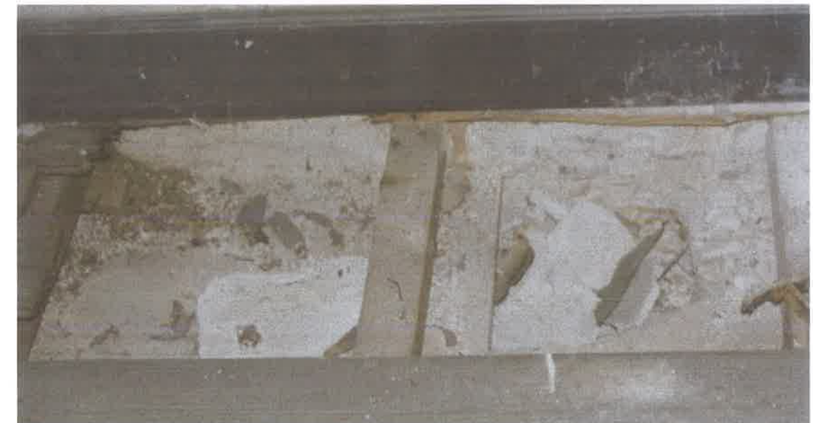
Φωτ. 6. χ. Α.09 νέο ξύλινο δάπεδο πάνω στην κατασκευή του δώματος
