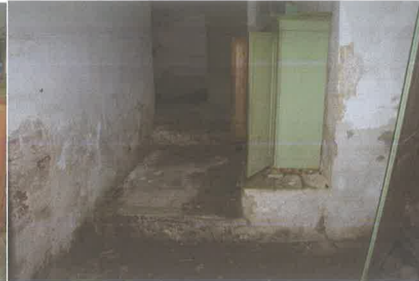
Φωτ. 234. χώρος Υ.03 σημερινή κατάσταση
