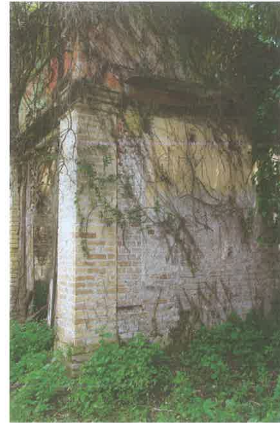
Φωτ. 49. χ.ΙΣ.05 γωνιακός πεσσός σε νοτιοδυτικό τοίχο
