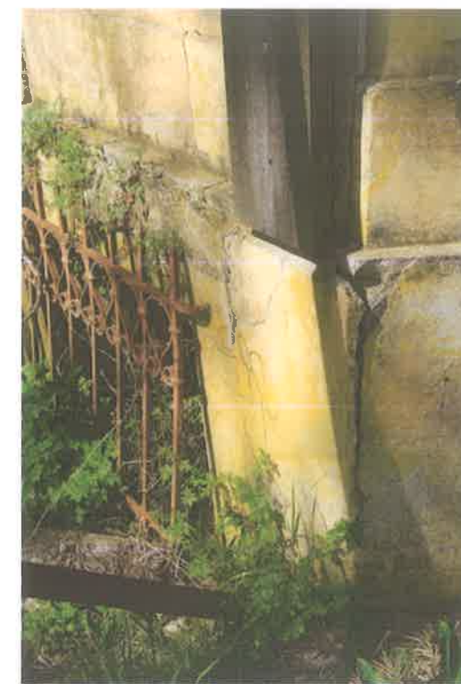
Φωτ. 199. μετακίνηση των λίθινων παραστάδων- πιθανή καθίζηση
