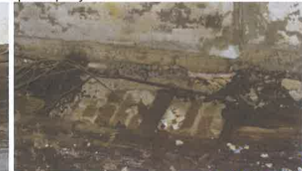
Φωτ. 7. χ.Α.03 το κυμάτιο της εξωτερικής όψης συνεχίζεται μέσα στην στέγη
