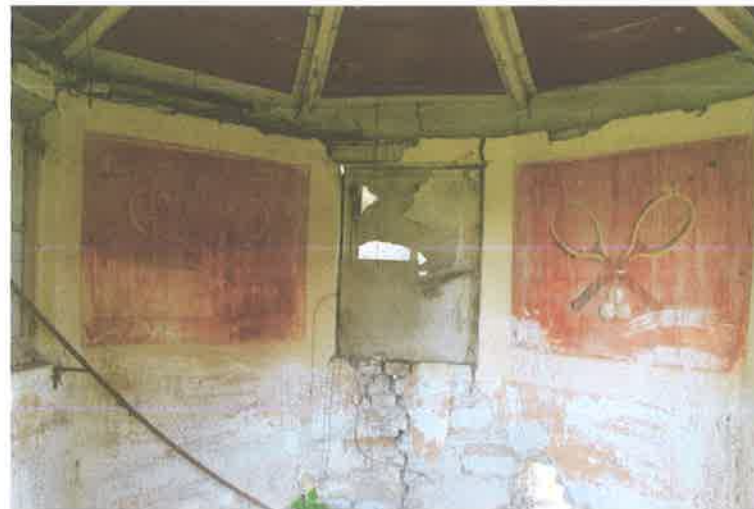
Φωτ. 87. εσωτερικό περιπτέρου
