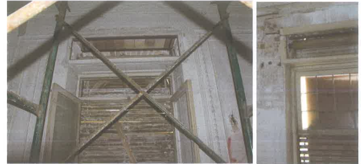
Φωτ. 26. Χώρος I.02 μεταλλικό πρέκι με πλήρωση από οπτόπλινθους σε συνδυασμό με ανακουφιστικό τόξο
