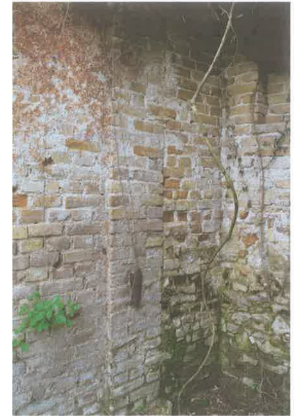
Φωτ. 50. χ.ΙΣ.06 διαμόρφωση πεσσού-ίχνη επιχρίσματος
