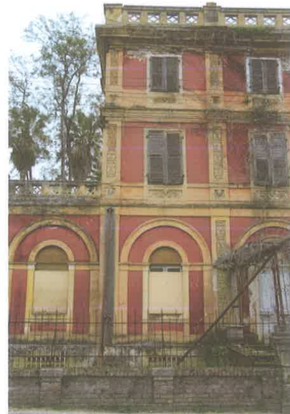
Φωτ. 175. φθορές στα κουφώματα/ρωγμές στο επίπεδο έδρασης των μεταλλικών δοκών οροφής β ορόφου/έντονη υγρασία στο επίπεδο του δώματος που ευνοεί την ανάπτυξη φυτικών οργανισμών
