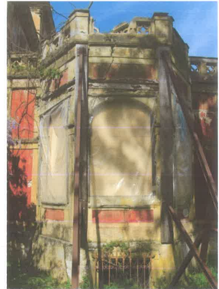
Φωτ. 95. Νοτιοανατολική όψη
