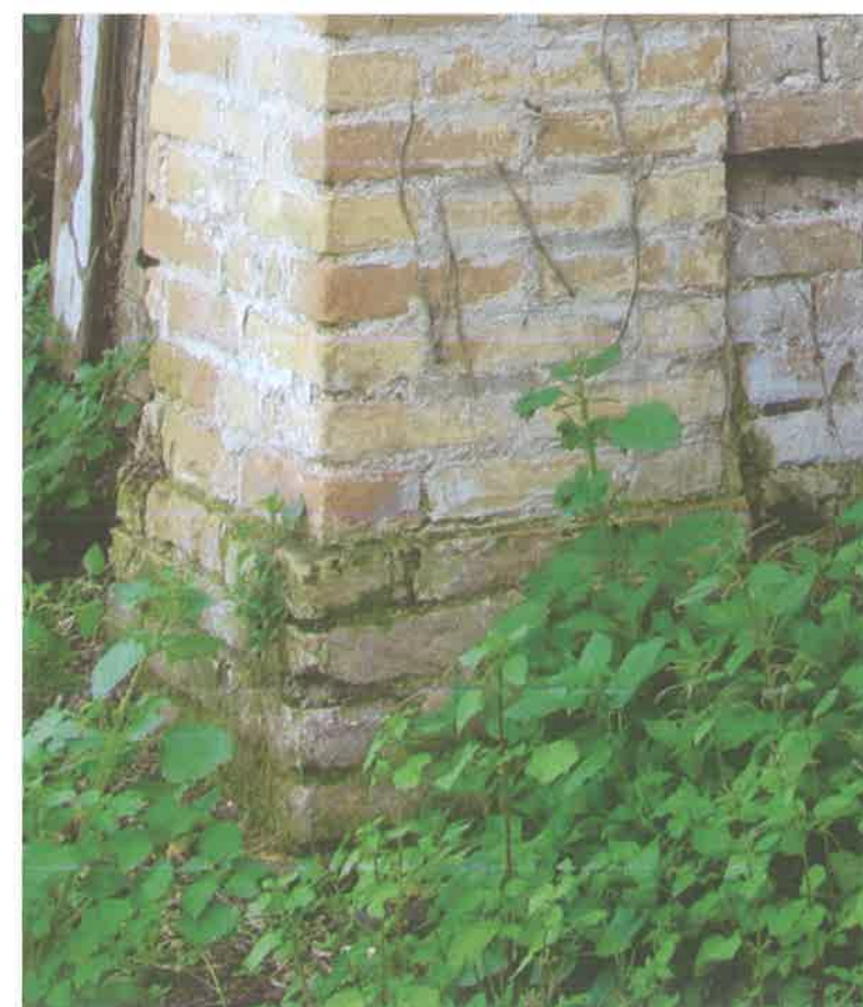
Φωτ. 58. χ.ΙΣ.05 έδραση τοιχοποιίας
