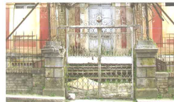
Φωτ. 114-115. Η κεντρική μεταλλική αυλόπορτα, στο μέτωπο της οδού Λευκίμης. Μεταλλικό κιγκλιδίωμα σε άνοιγμα του ημιυπόγειου χώρου Πηγή: ερευνητικό
