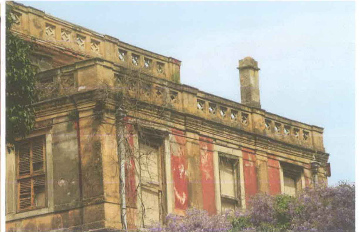
Φωτ. 101. Αποψη τμήματος της νοτιοανατολικής όψης, στην οποία διακρίνονται οι διακοσμητικές παραστάδες, ο γωνιακός πεσσός και το γείσο επίστεψης στη βάση του στηθαίου
