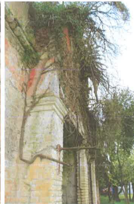
Φωτ. 84. ίχνη λεπτού επιχρίσματος στην επιδερμίδα της κύριας όψης
