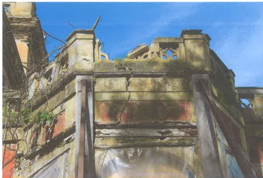
Φωτ. 196. Οξείδωση των δοκών ανοιγμάτων και αποκόλληση των επιχρισμάτων
