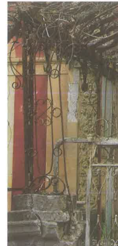
Φωτ. 90. στέγαστρο και αυλόθυρα εισόδου
