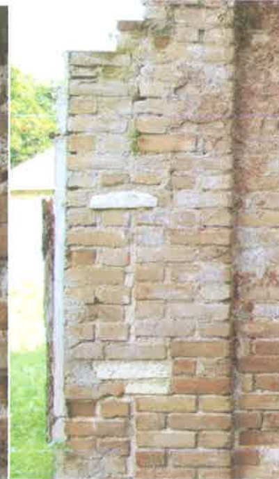
Φωτ. 52. χ.ΙΣ.06 σημειακό κλείδωμα κατασκευής-ίχνη ξύλινης κάσας
