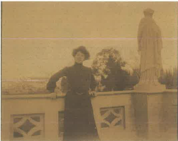
Εικόνα 51-52. Πηγή: Ερευνητικό Ε.Μ.Π. (από αρχείο Α. Μεταλληνού) Παλαιότερες φωτογραφίες από τις οποίες τεκμηριώνεται η ύπαρξη αγαλμάτων γυναικείων μορφών στα στηθαία του κτίσματος.
