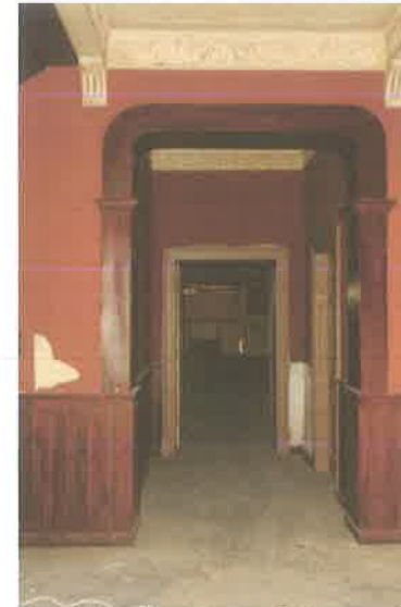
Φωτ. 119. Η χρήση του ξύλου ως υλικού επένδυσης σε τμήμα της τοιχοποιίας του χώρου εισόδου Ι.01 Φωτ. 120. "Φατνωματική" οροφή στο χώρο Ι.01 _ Πηγή: Ερευνητικό Ε.Μ.Π.
