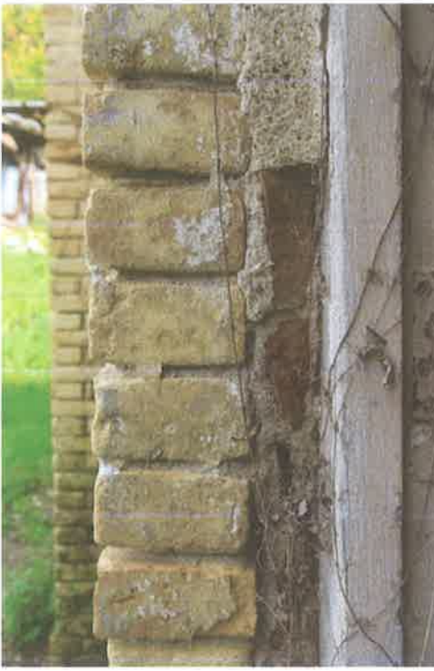
Φωτ. 71. κενό μεταξύ επιδερμίδας και υφιστάμενης κάσας στην κύρια όψη
