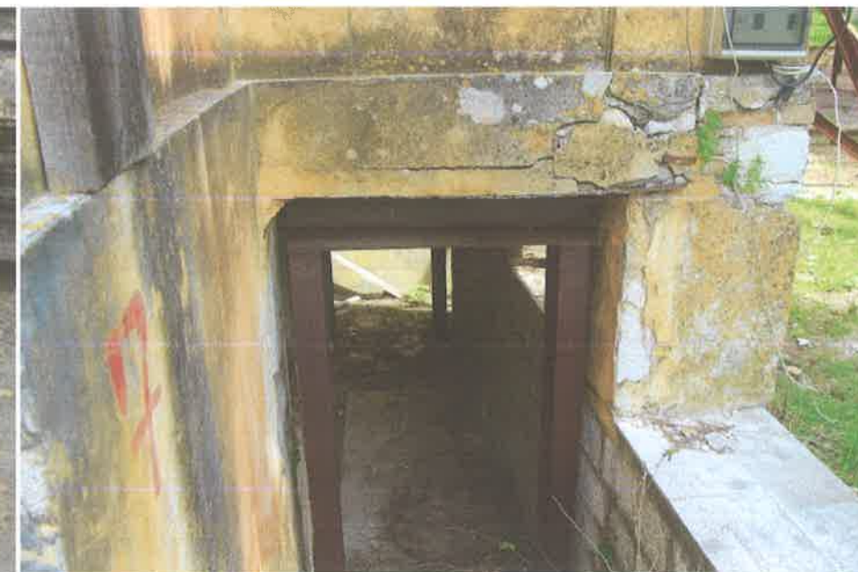
Φωτ. 213. αντιστήριξη εισόδου στο υπόγειο
