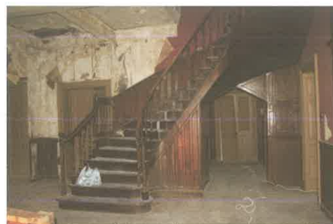
Εικόνα 33. Το κεντρικό κλιμακοστάσιο στο χώρο υποδοχής (I.01)
