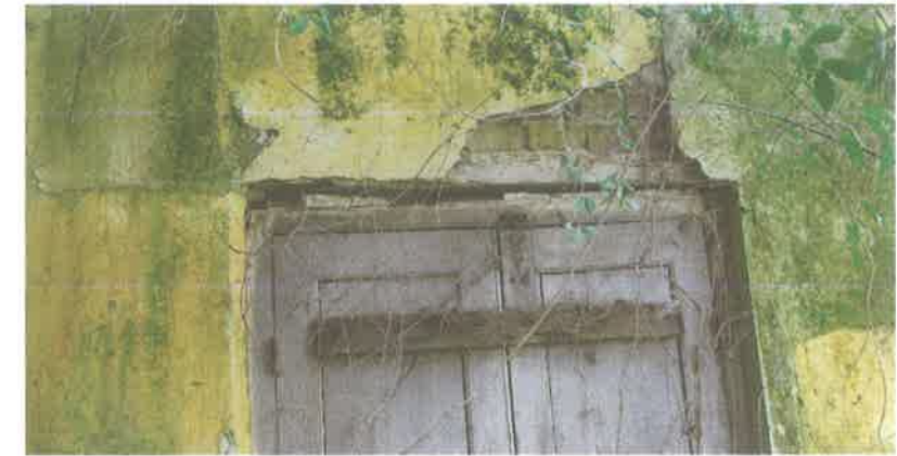
Φωτ. 68. χ.ΙΣ.05 εσωτερικό ξύλινο πρέκι
