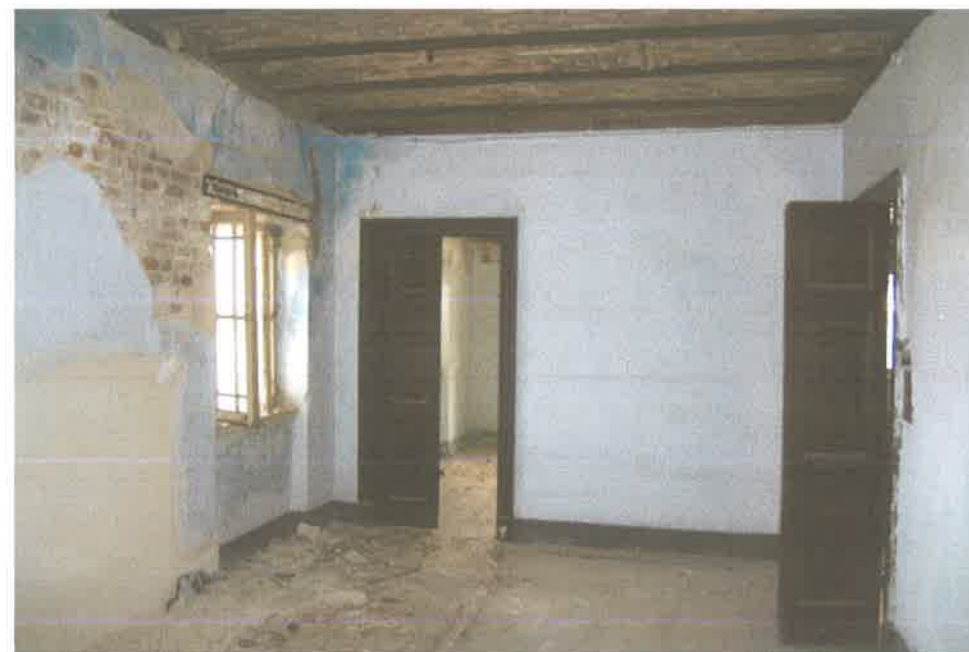
Εικόνα 42. Χώρος υπνοδωματίου στο Β' όροφο (B.04)
