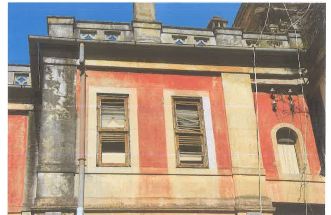
Φωτ. 201. φθορά κουφωμάτων-επιχρισμάτων, ανάπτυξη φυτικών μικροοργανισμών
