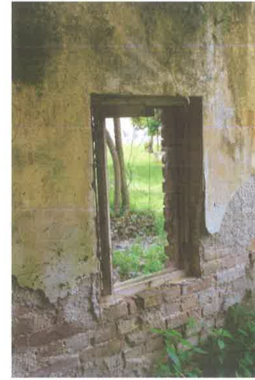
Φωτ. 71. κενό μεταξύ επιδερμίδας και υφιστάμενης κάσας στην κύρια όψη
