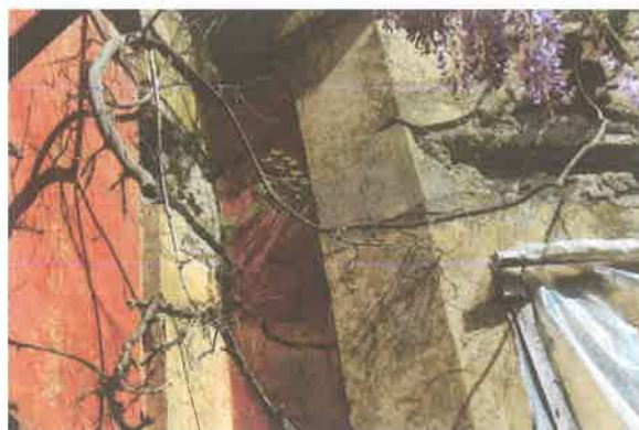
Φωτ. 196. Οξείδωση των δοκών ανοιγμάτων και αποκόλληση των επιχρισμάτων
