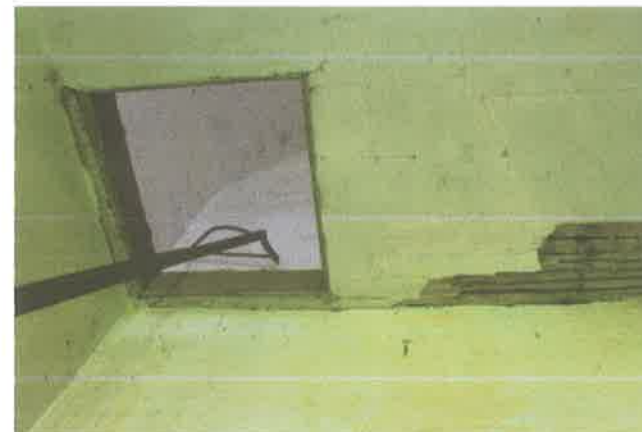
Φωτ. 38. χ.ΙΣ.03 μεταλλική κλίμακα ανόδου στον όροφο
