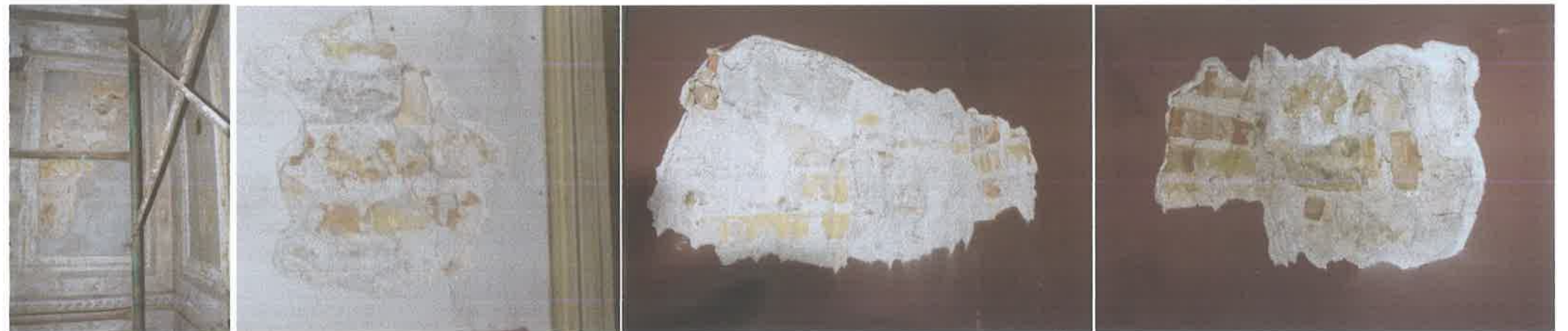
Φωτ. 12. χ. Ι.02 λιθοδομή Φωτ. 13. χ. Ι.04 μικτή τοιχοποιία Φωτ. 14. χ. Ι.10 συνάντηση δύο κατασκευαστικών φάσεων με διαφορετικά είδη τοιχοποιίας Φωτ. 15. χ. Ι.10 συνάντηση μικτής τοιχοποιίας με οπτοπλινθοδομή α φάσης
