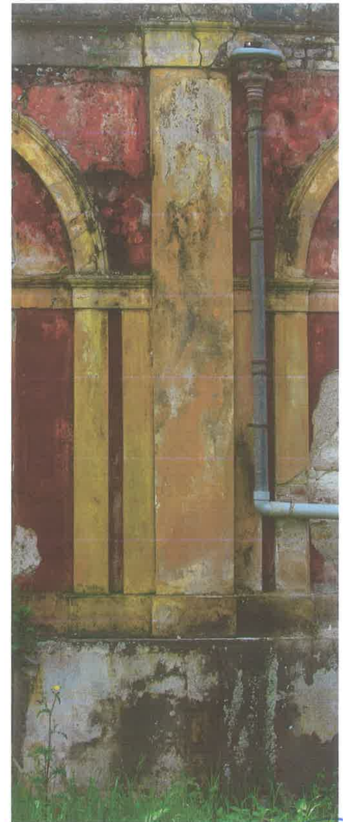
Φωτ. 34. Βορειοανατολική όψη
