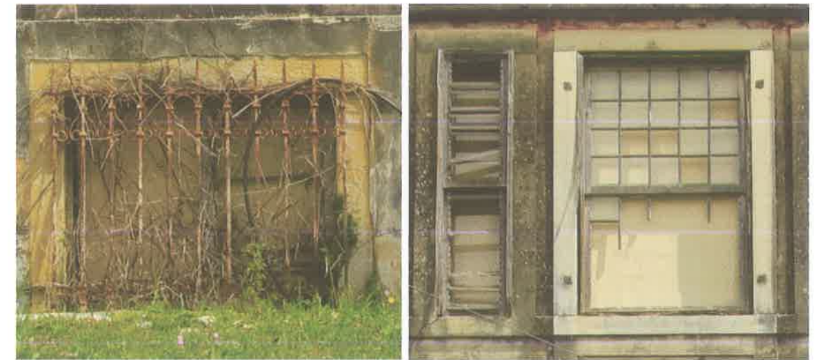
Φωτ. 28. σιδεριές από μασίφ μεταλλικές διατομές στη νοτιοδυτική όψη
