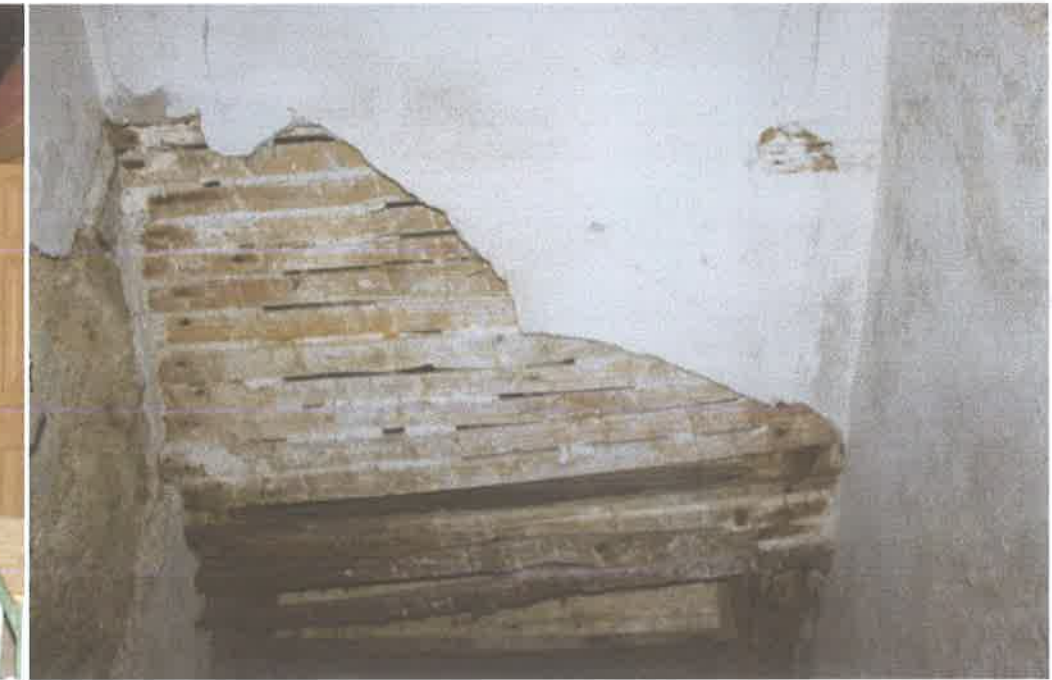
Φωτ. 37. χ. Υ.04 ξύλινη σκάλα υπογείου-ουρανός με μπαγδατί
