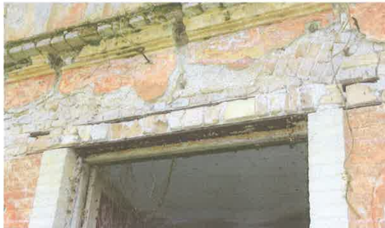
Φωτ. 69. εξωτερικό μεταλλικό πρέκι στην κύρια όψη
