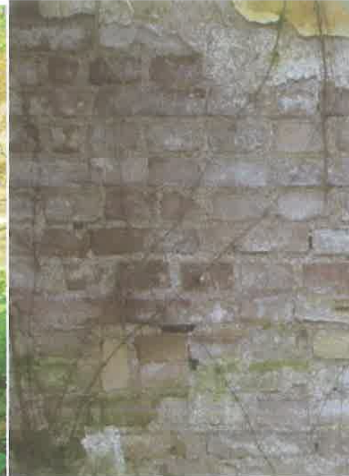
Φωτ. 55. χ.ΙΣ.05 κατασκευή τοίχου
