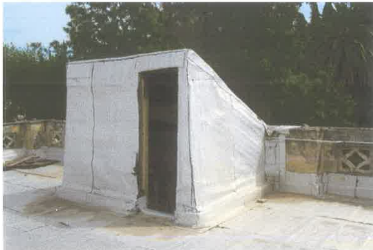
Εικόνα 40. Η απόληξη του κλιμακοστασίου στο δώμα της οικίας
