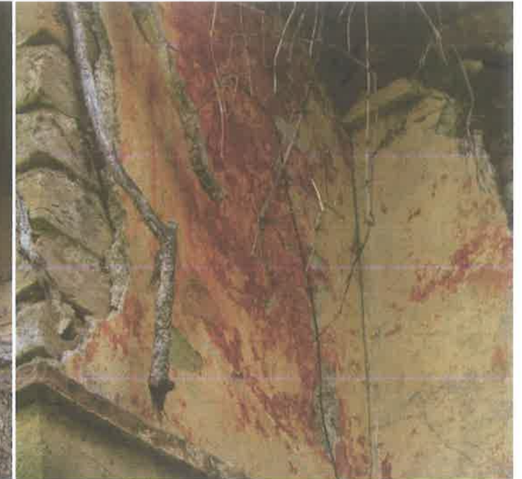
Φωτ. 83. διαδοχικές στρώσεις χρώματος στην κύρια όψη
