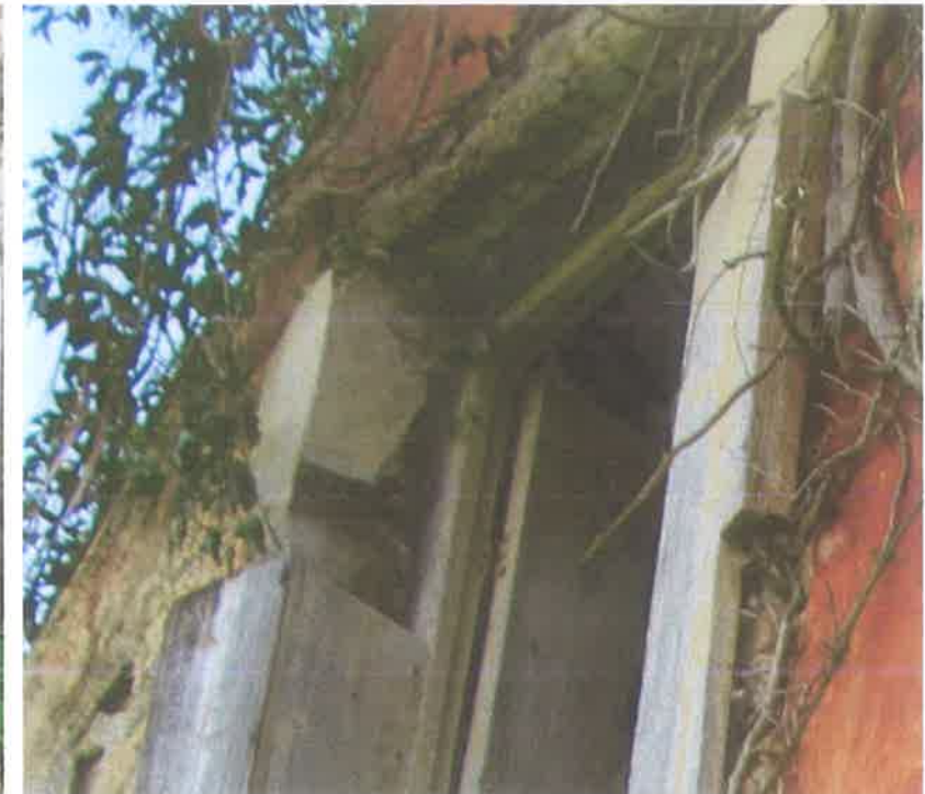
Φωτ. 77. Θύρα ορόφου στην κύρια όψη
