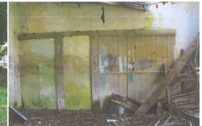
Φωτ. 40. χ.ΙΣ.04 ίχνη ξύλινης επένδυσης στους τοίχους
