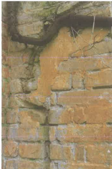
Φωτ. 84. ίχνη λεπτού επιχρίσματος στην επιδερμίδα της κύριας όψης
