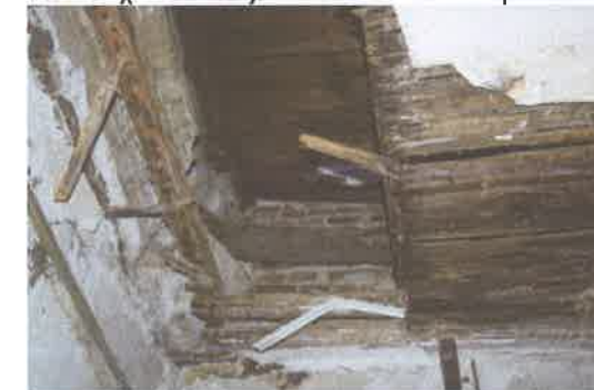
Φωτ. 7. χ.Α.03 το κυμάτιο της εξωτερικής όψης συνεχίζεται μέσα στην στέγη
