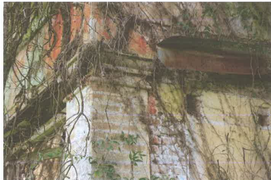
Φωτ. 66. χ.ΙΣ.05 διαγράφεται το ίχνος της κεκλιμένης στέγης και οι θέσεις των δοκών στήριξης οροφής
