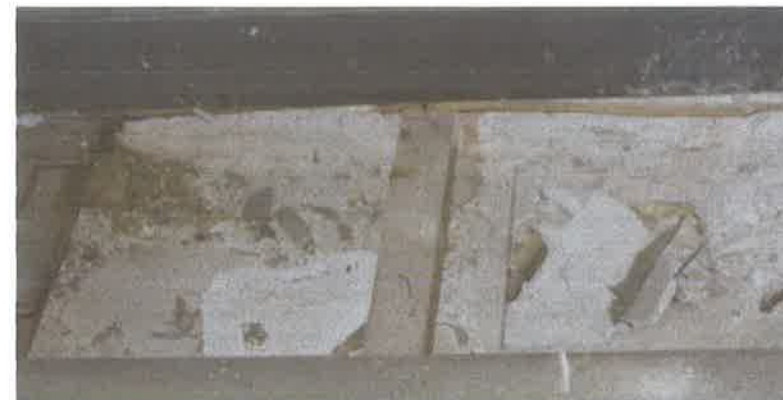
Φωτ. 25. χ. Α.09 ξύλινο δάπεδο
