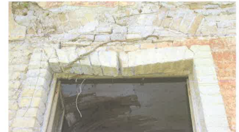
Φωτ. 70. κορνίζα οπτόπλινθων σε συνδυασμό με ανακουφιστικό τόξο
