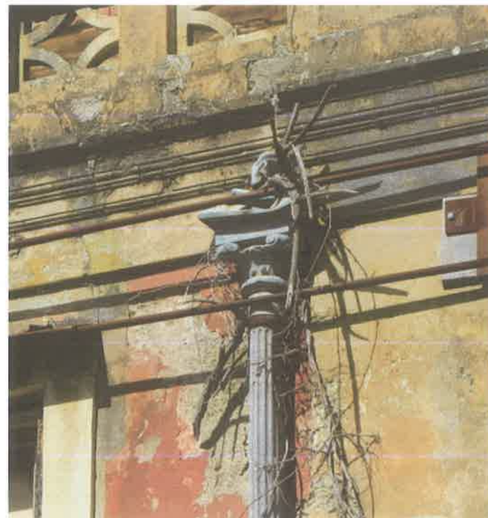
Φωτ. 102-103. Φυτικός διάκοσμος στις υδρορροές του κτίσματος
