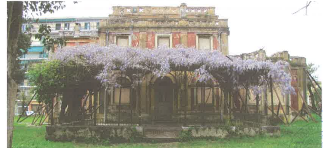
Φωτ. 94. Ο ημιυπαίθριος χώρος στο κέντρο της νοτιοανατολικής όψης
