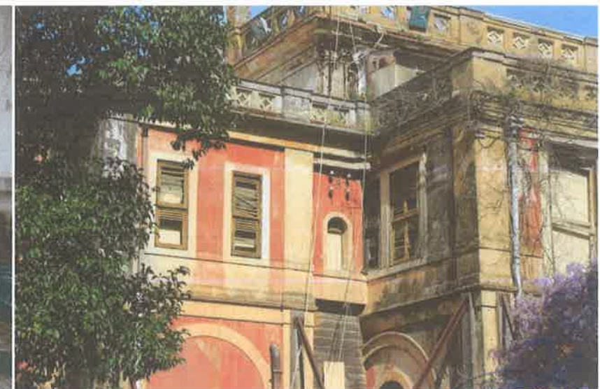
Φωτ. 220. νοτιοανατολική όψη
