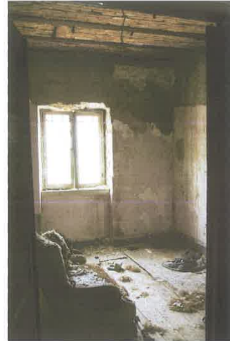
Φωτ. 134. αποκόλληση επιχρισμάτων τοίχων και οροφής
