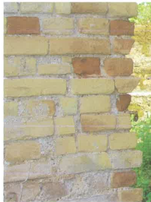
Φωτ. 54. χ.ΙΣ.01 κατασκευή τοίχου
