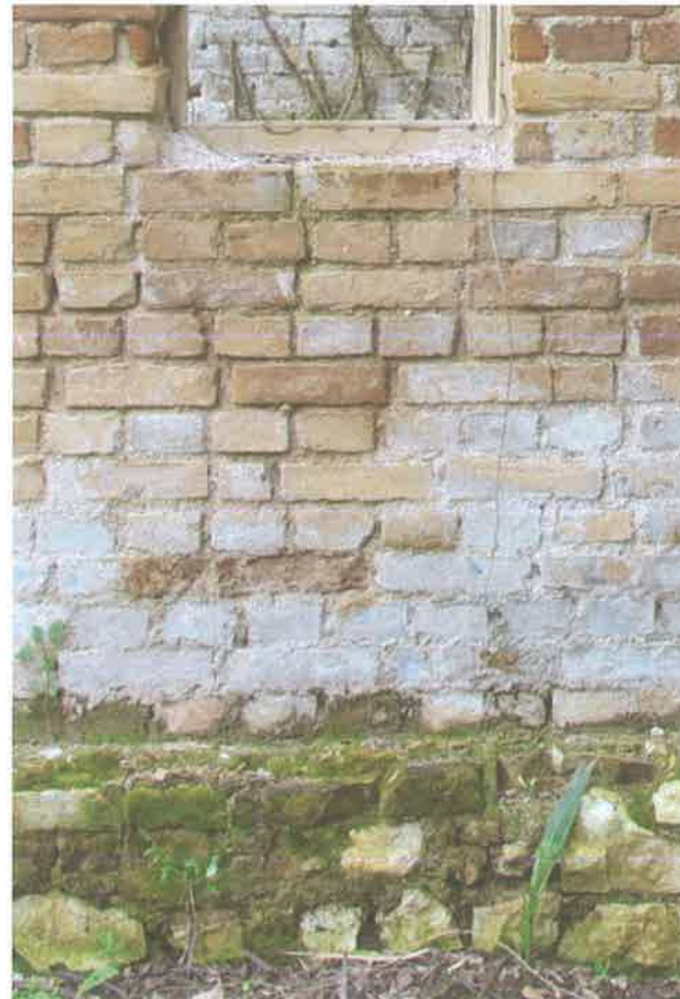
Φωτ. 57. χ.ΙΣ.06 έδραση τοιχοποιίας
