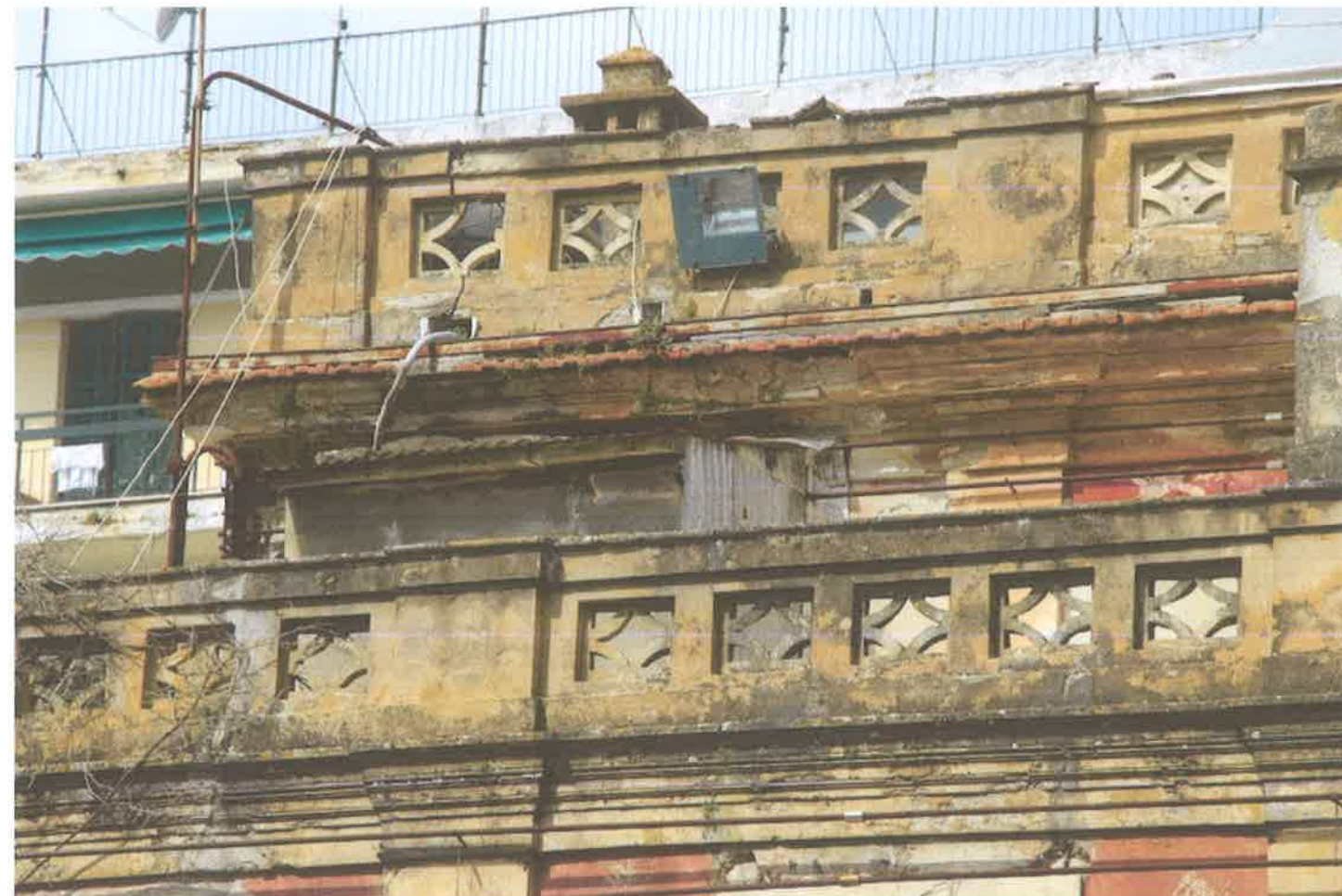
Φωτ. 206. πρόχειρη κατασκευή w.c. β ορόφου
