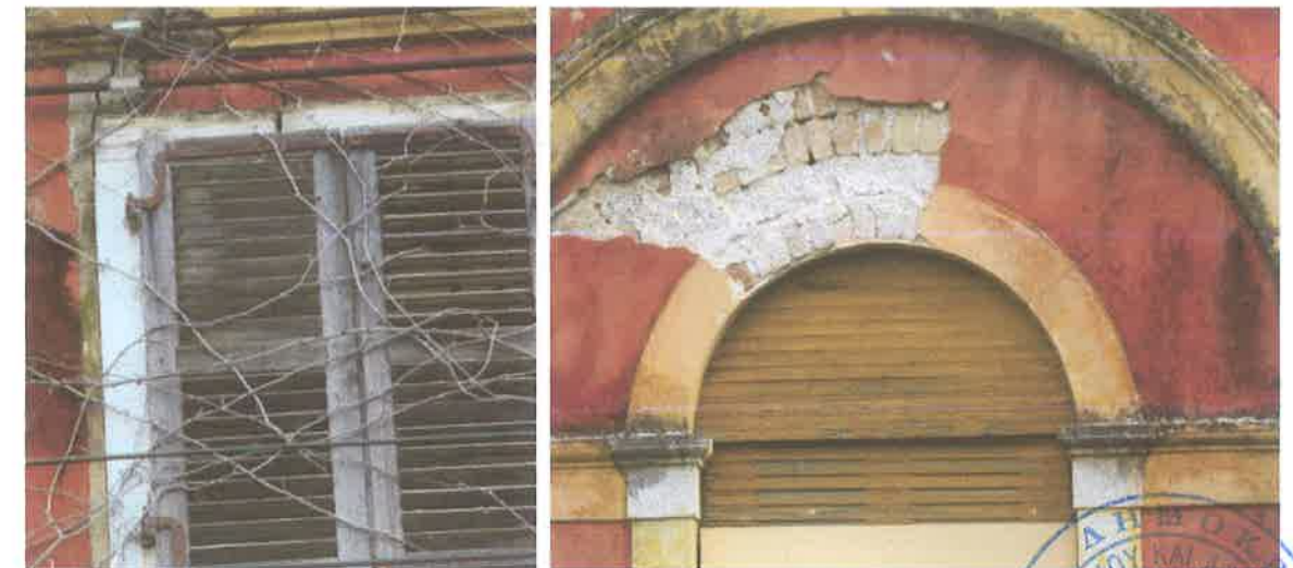
Φωτ. 30. κούφωμα με ξύλινες περσίδες β ορόφου, στην κύρια όψη
