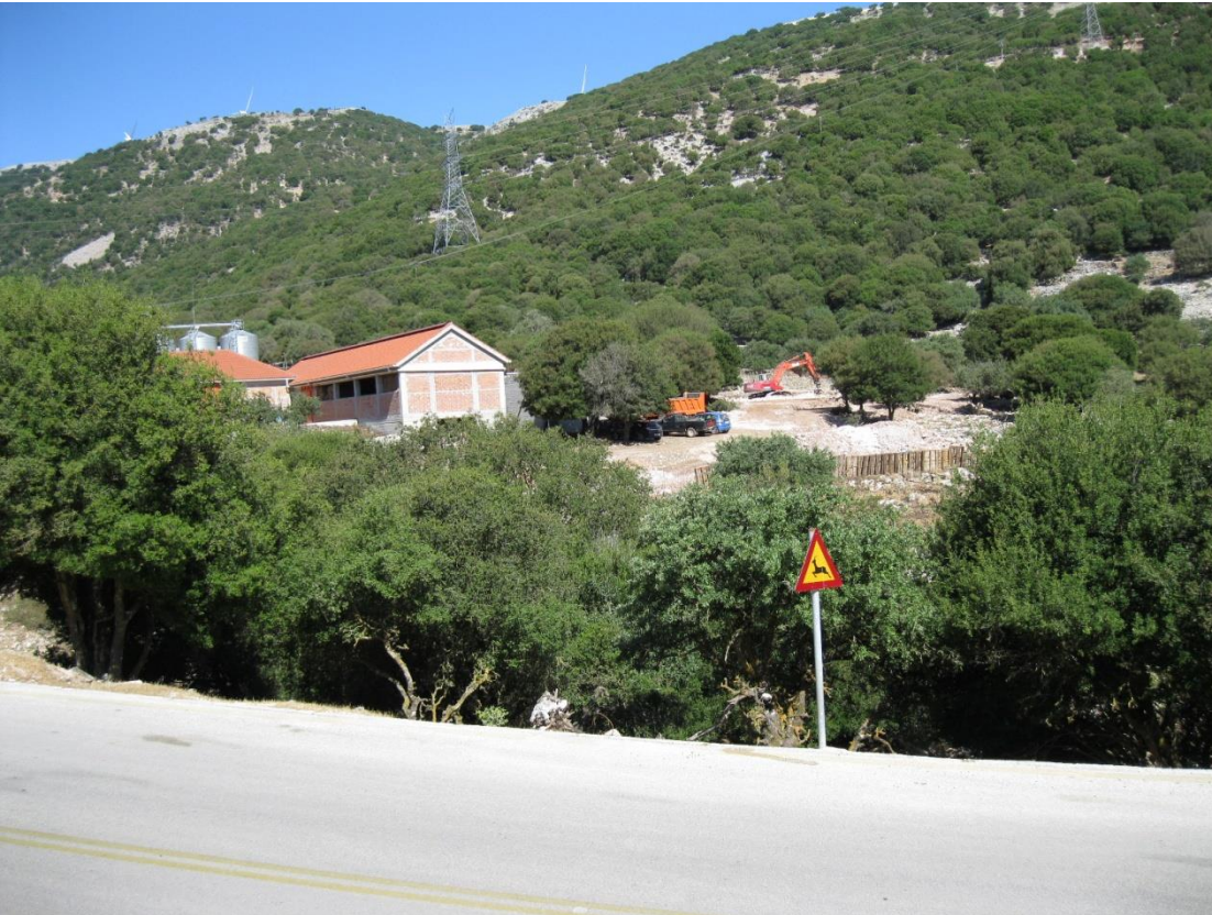
από τις οικοδομικές εργασίες του νέου σφαγείου
